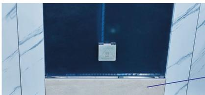
4 - Fixez le "L" de protection en acier inoxydable en bas de la partie centrale à l'aide de deux vis 4\*45.
