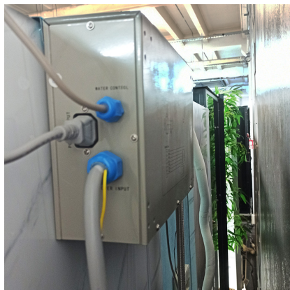
Exemple de fixation du générateur en hauteur, derrière la cabine
